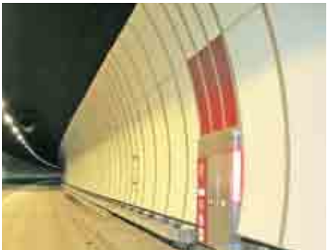
Cuilfail Tunnel | Lewes | Großbritannien
