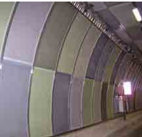
Schallschutzpaneele | Tunnel Dogana Como | Italien
