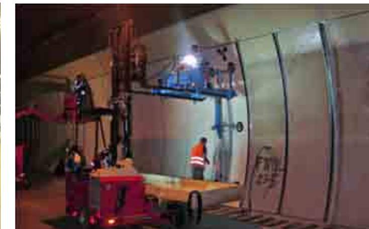
Tunnelmontage gebogene Paneele
