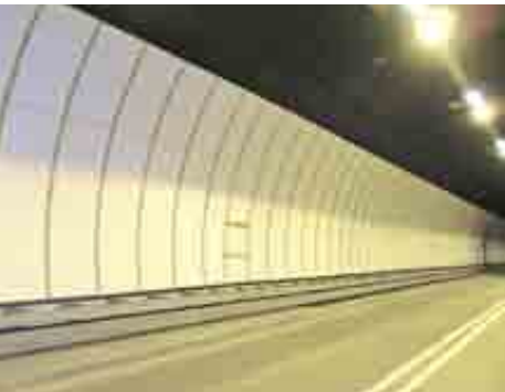
Cuilfail Tunnel | Lewes | Großbritannien
