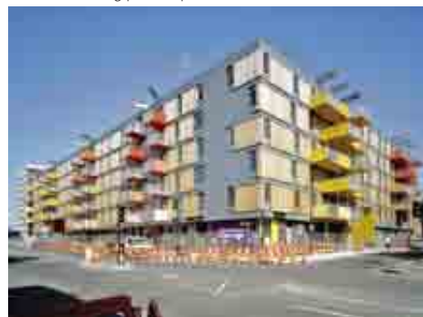
Balkonverkleidung | London | Großbritannien
