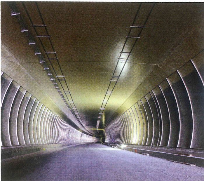
Abbildung 72: Emaillierte Paneele - Unterkonstruktion
